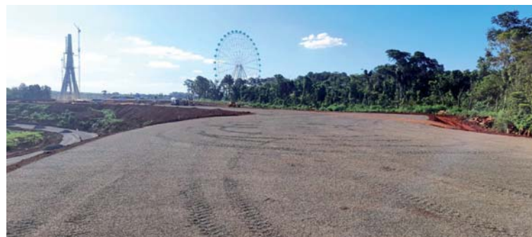
Obras da Perimetral Leste avança na região do Porto Meira
