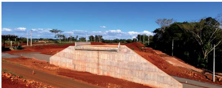
Viaduto no entroncamento da BR 469 já foi concluído
