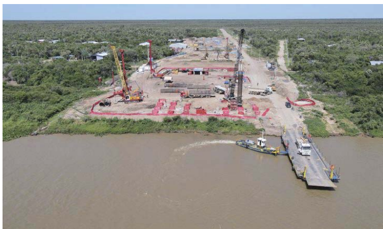
Projeto da nova ponte ligando Porto Murtinho (BR) à Carmelo Peralta (PY)
