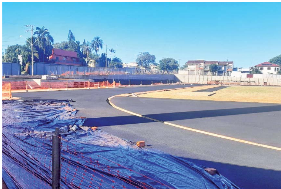
Avançam as obras da pista de atletismo padrão internacional
