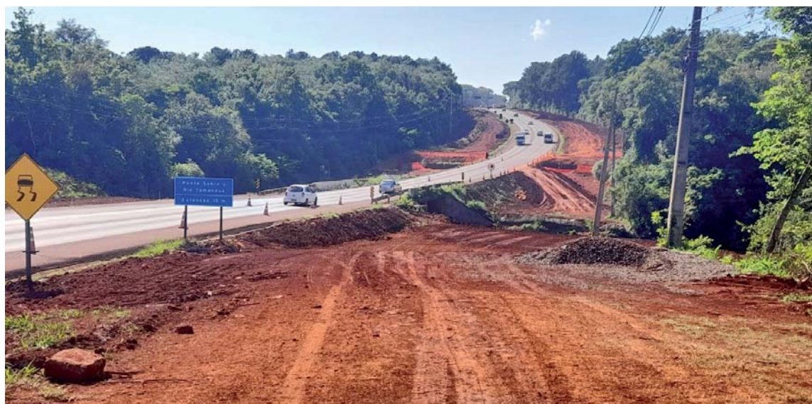
Obras de duplicação da Rodovia das Cataratas estão em andamento
