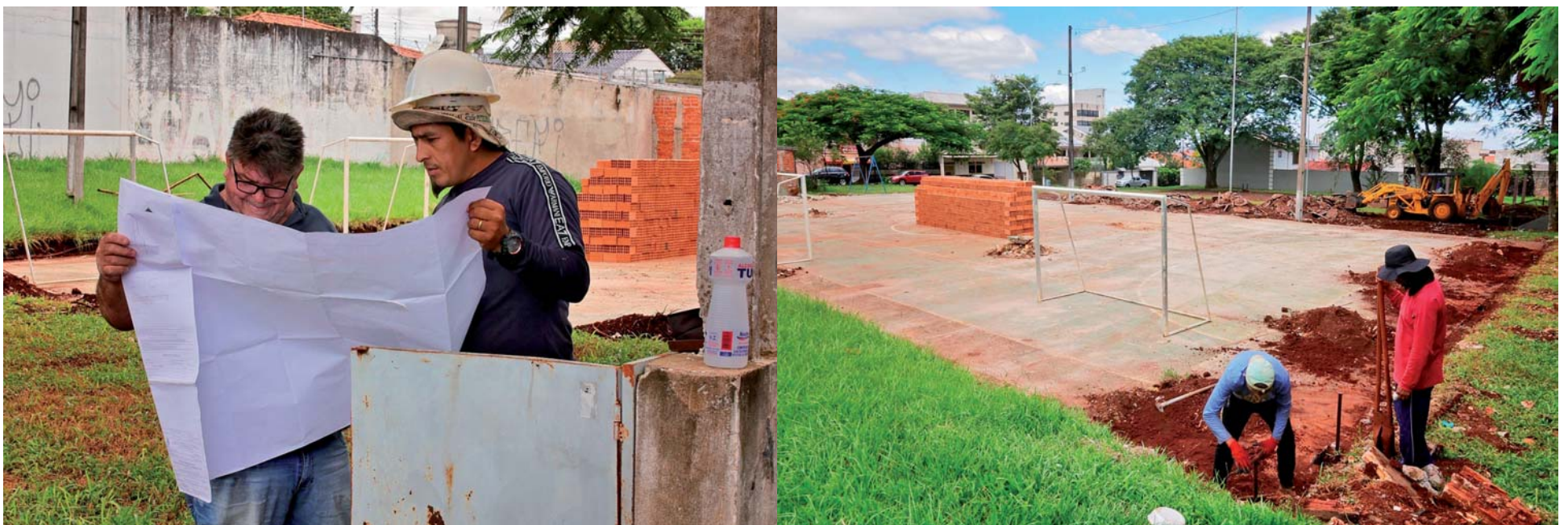
Quadra já está sendo reformada
